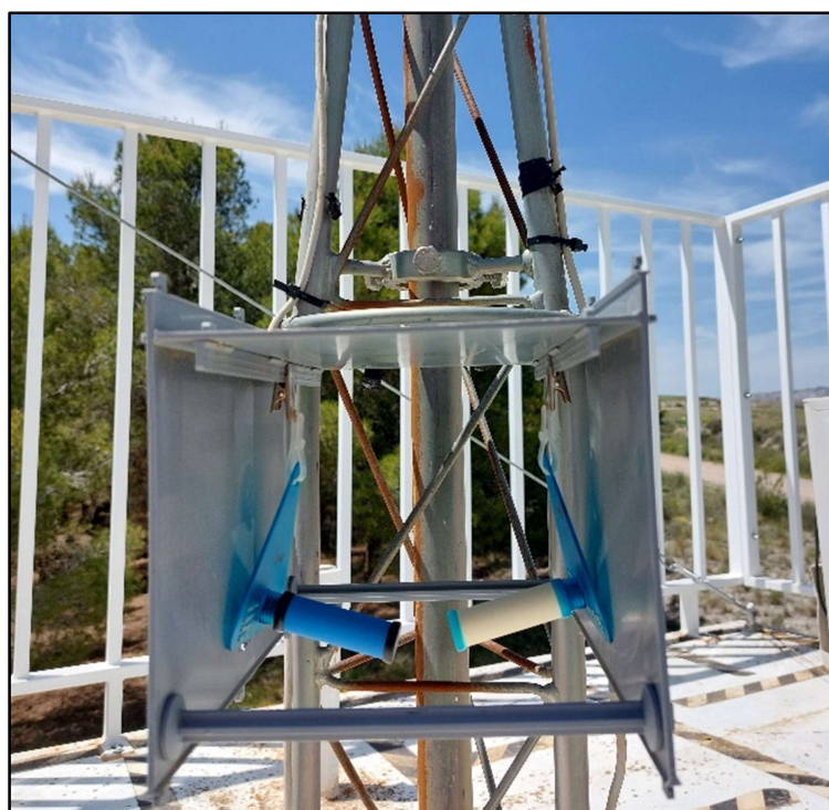
Fotografía 1. Instalación de Pasivos Radiello
