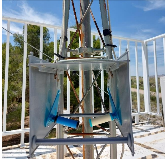
Fotografía 1. Instalación de Pasivos Radiello
