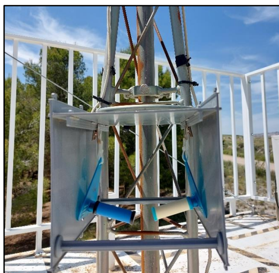
Figura 3. Instalación de Pasivos Radiello Fuente: Propia
