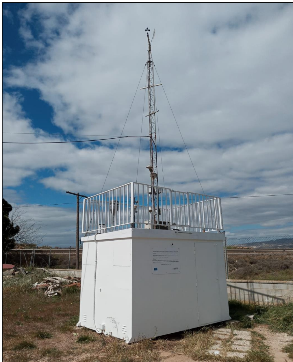
Figura 7. Ubicación Estación de Alagón Fuente: Propia
