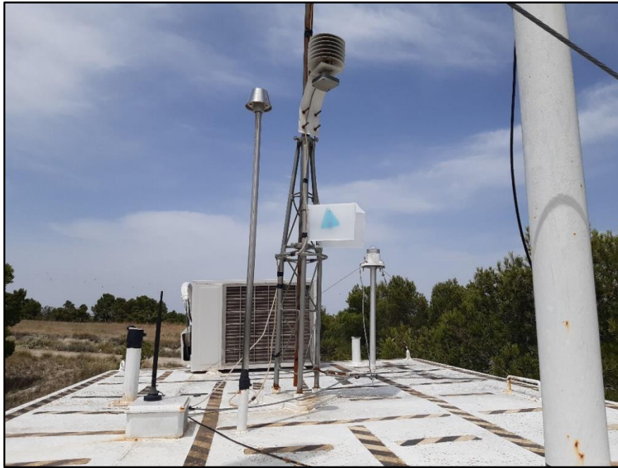
Figura 3. Instalación de Pasivos Radiello Fuente: Propia
