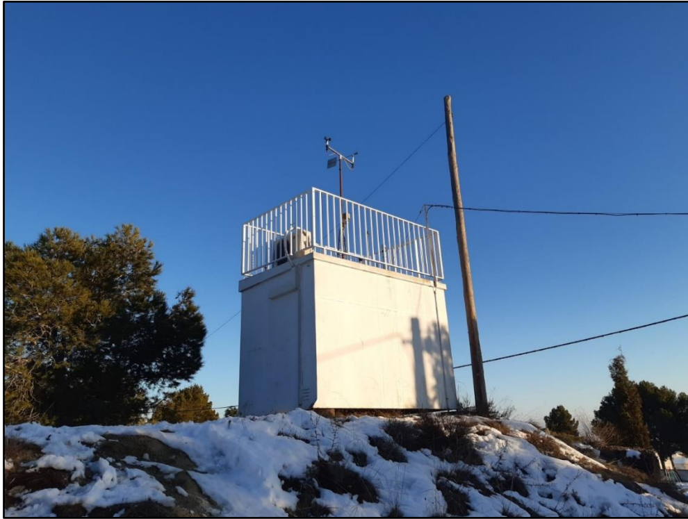
Figura 6. Estación de Bujaraloz Fuente: Propia
