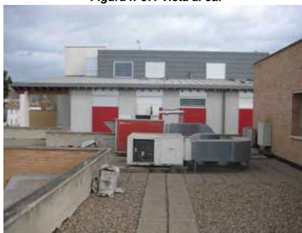
Figura nº39: Vista al este
