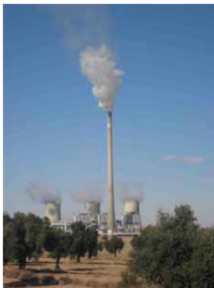
Figura nº18: Vista de la Central Térmica de Andorra.
