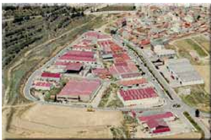
Figura nº19: Vista del polígono industrial "LA UMBRIA"
