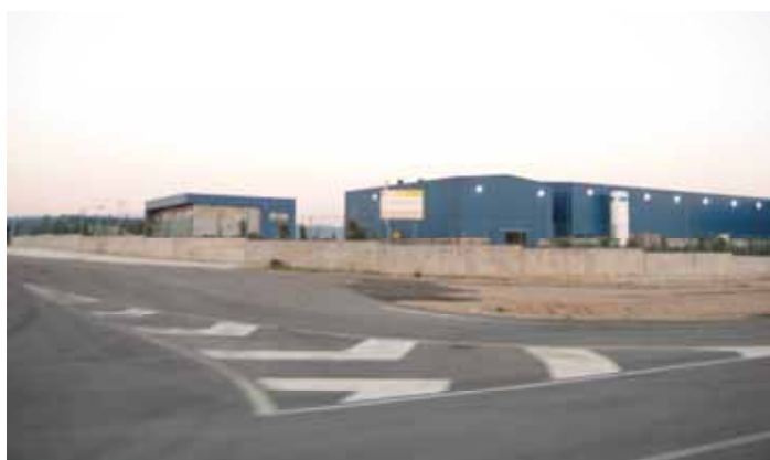
Figura nº93: Imagen de las instalaciones de Recobat.
