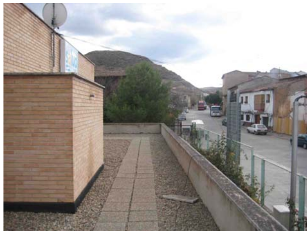
Figura nº32: Vista al sur
