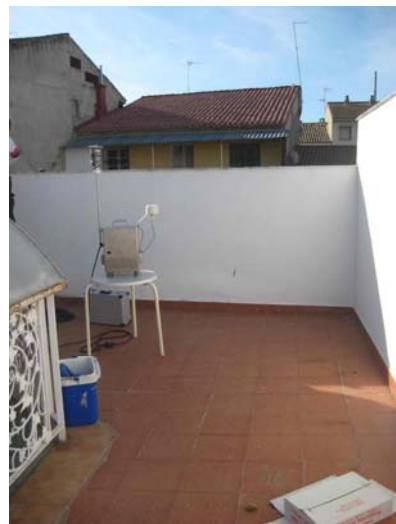
Figura nº64: Vista al sur
