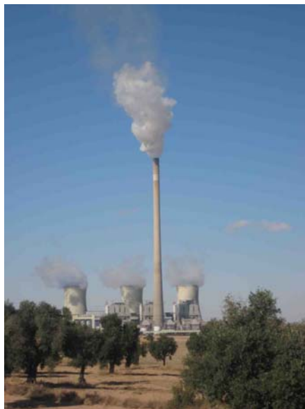
Figura nº13: Vista de la Central Térmica de Andorra.
